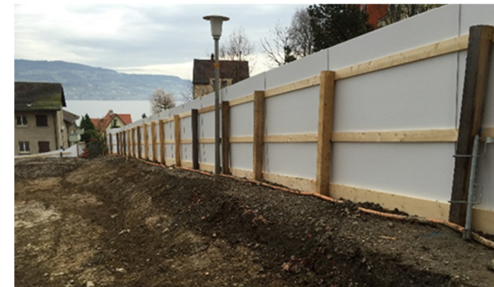
Schutz gegen Hochwasser kombiniert mit der Baustellentrennwand
