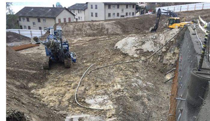
Beginn Absenkung der Baugrube nach der Altlastensanierung
