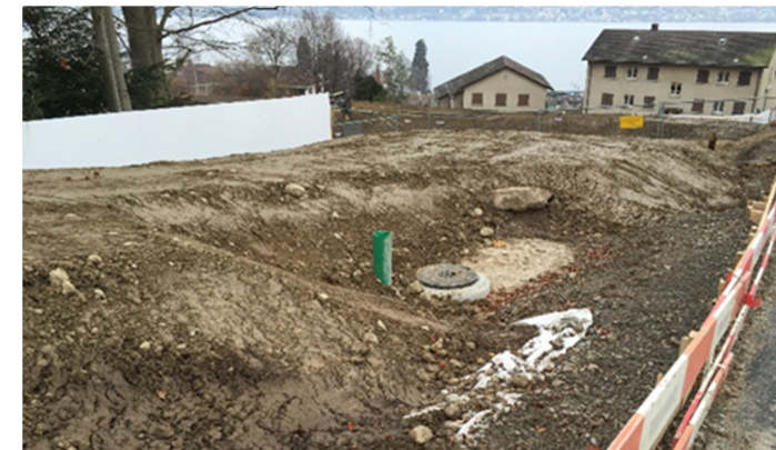
Zwischendepot von geeignetem Aushubmaterial für die Hinterfüllung
