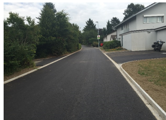
Parkstrasse nach der Sanierung
