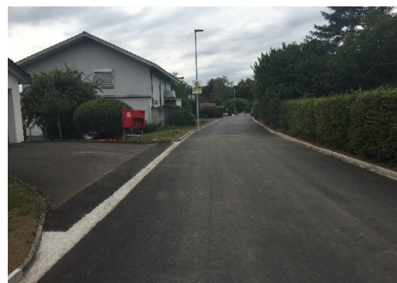
Parkstrasse nach der Sanierung
