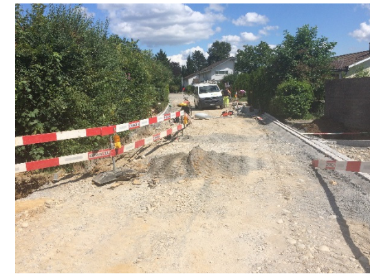
Strassen- und Werkleitungsbau auf engem Raum. Zufahrt zu den Liegenschaften war jederzeit möglich.
