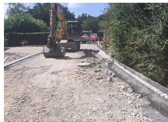
Kompletter Kofferersatz, Randabschlüsse
